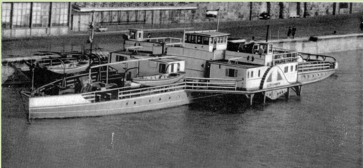
68. ábra. „Széchenyi” elektromos hajtású lapátkerekes folyami vontatóhajó
